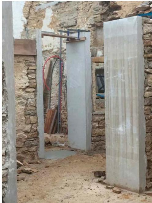
Renforcement des jambages des passages créés dans les murs en pierre: monolithes en croûte de pierre de Villebois (2,6m x 0,6 m x 0,2m)
