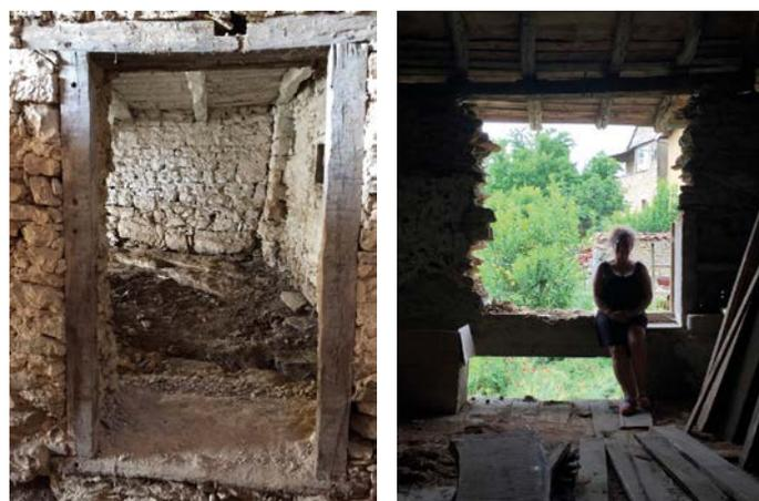
La géométrie des murs existants négocie avec le « bon sol » en jouant des affleurements rocheux. Les pierres juste dégrossies des murs sont bloquées par de la terre. Le rocher affleurant est la seule fondation et offre une habitation parfaitement drainée, à l'abri de toute humidité.
